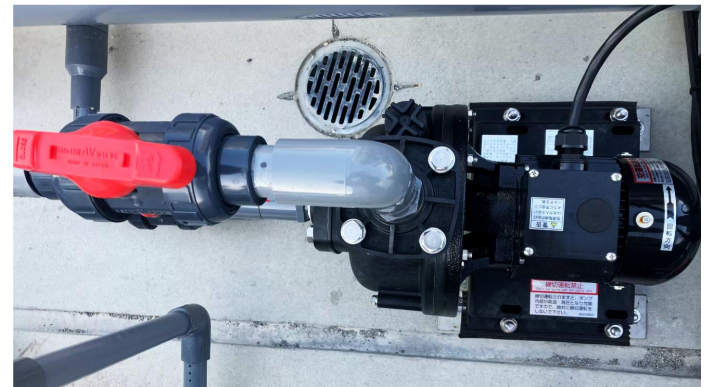
ポンプ交換で複数水槽停止
