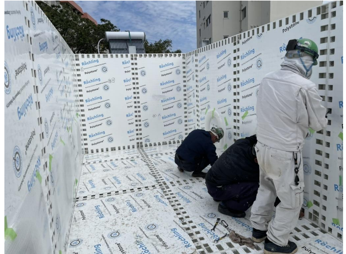
樹脂パネルの現場組み立てによる水槽コンテナ製作
