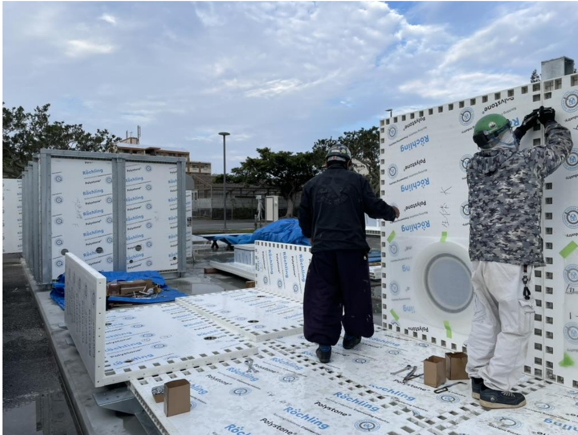
樹脂パネルの現場組み立てによる水槽コンテナ製作
